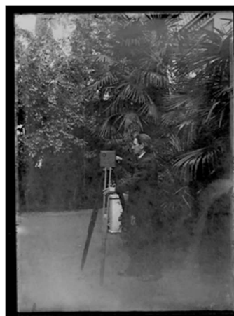
F. H. Lavanchy-Clarke, Cannes, um 1900 ,© Fondation Herzog Basel
