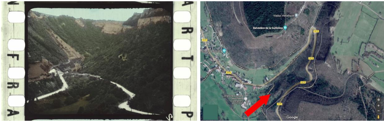
Abb. 9: Die Creux de Revigny, links im Film und rechts aus Google Maps, mit Pfeil in Richtung der Filmaufnahme. Die Zugschienen verlaufen praktisch parallel zur Strasse und teilweise durch einen Tunnel mit 348 m Länge und enger Kurve, dessen oberer Eingang im Fotogramm auf der rechten Seite im bewaldeten Bereich zu sehen ist 16 .
