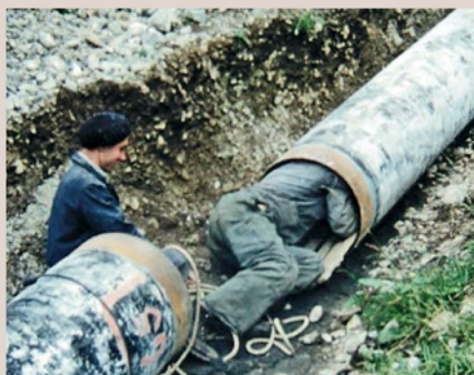
16-mm-Film vom Kraftwerksbau am Obersee bei Näfels, 1963. Filmstill: Glarner Industriefilme GIW
