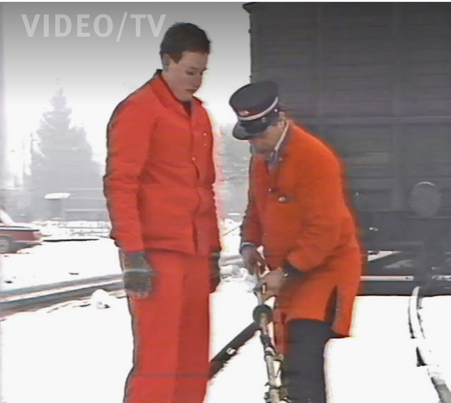
SBB Lehrfilm «Arbeitsinstruktion: Ausschalten und Erden der Fahrleitung» (1986). Videostill: SBB Historic
