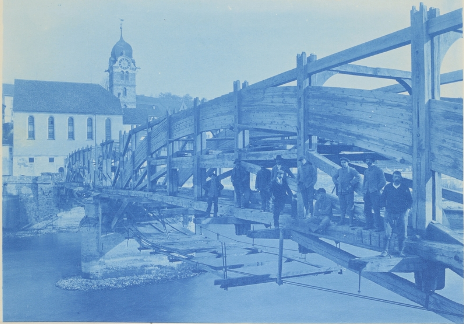
Z 3369 Rhein. Eglisau, alte Brücke, Abbruch, 13. XI. StAZH Z 451.587.16
