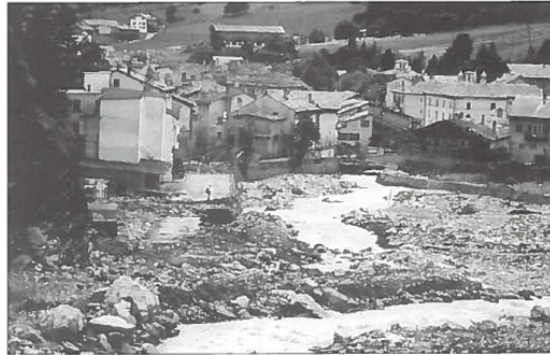
Ein Bild der Zerstörung: weggespülte Strasse nach dem Unwetter vom Juli 1987.
