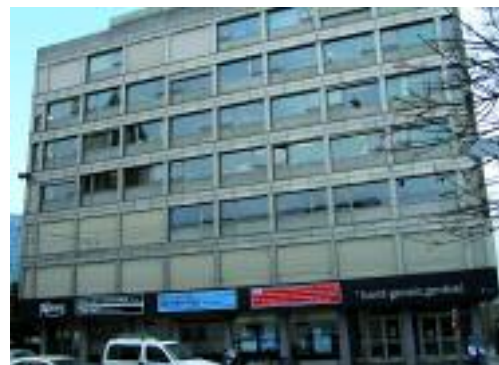
Les locaux du Centre pour l'image contemporaine à Saint Gervais au centre de Genève.
