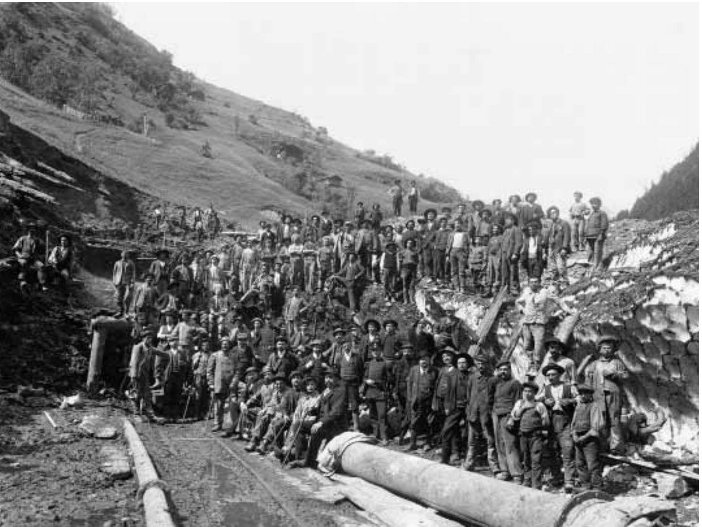
Giovanni Ruggeri: Tête-sud Goppenstein (Valais). Ouvriers sur le chantier
